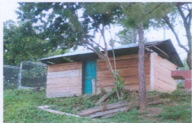
Foto 4: Vista general de la cocina, tiene oportunidad de intervención en la puerta, pintura interior y exterior, canales y bajadas de agua pluvial.
