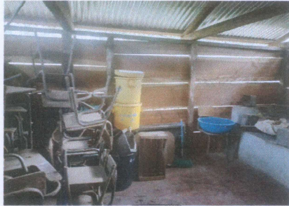
Foto 2: Mejoramiento de pared de cocina con mampostería de block.
