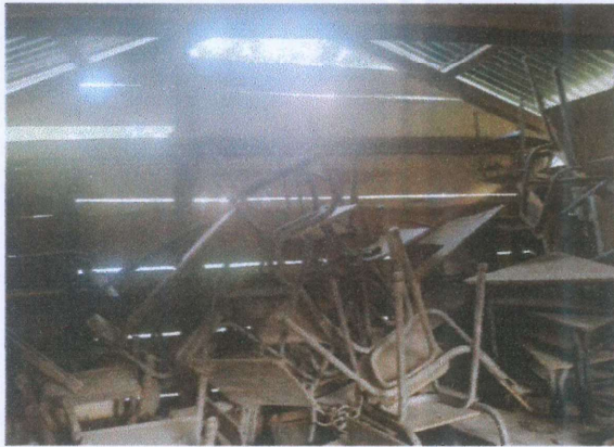
Foto 3: Mejoramiento de cocina con techo de lámina troquelada calibre 26 y estructura metálica tipo pórtico debido a su mal estado.
